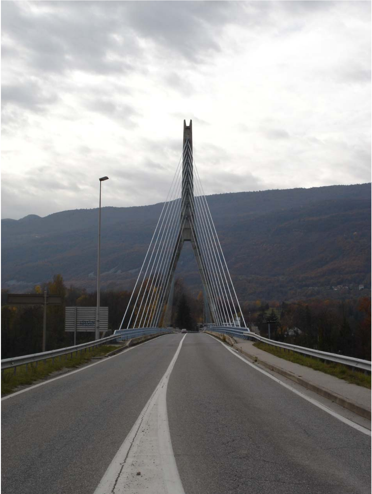
Nye Seysell bru: Skråstagsbru med spiralslått lukket kabel
