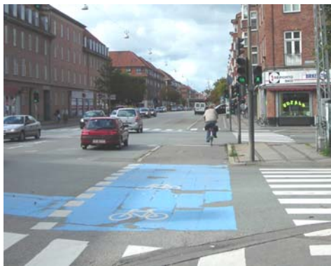
Foto nr.3: I kryss er sykkelvegen synliggjort med blåfarge og sykkelsymbol.
