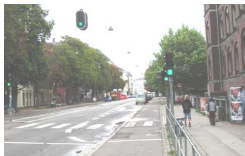
Foto nr.2: Fotgjengerfeltet starter ved fortauskanten og går over sykkelvegen.
