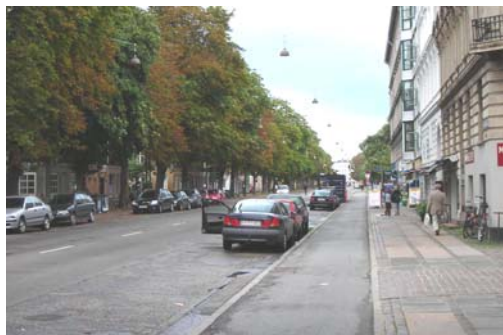
Foto nr.1: Sykkelvegen har et eget nivå som er høyere enn kjørebanelen og lavere enn fortauet.
