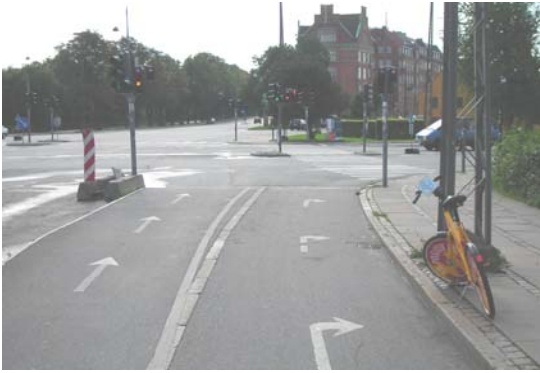
Foto nr.5: I store kryss med mye sykkeltrafikk er det flere felt og egne trafikkllys for syklister.
