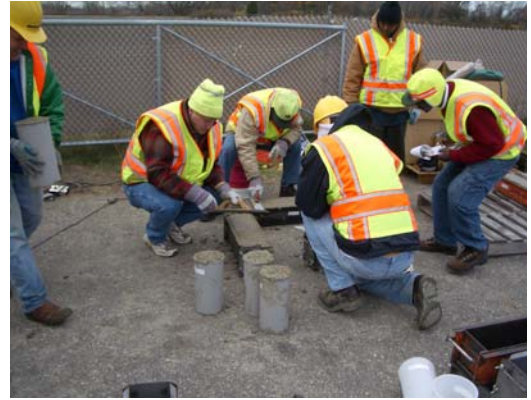
Prøvetaking under støpearbeidene
