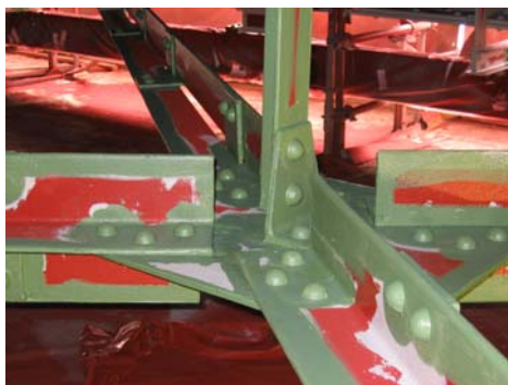
Storstrømsbroen - udstikning af vindkryds
