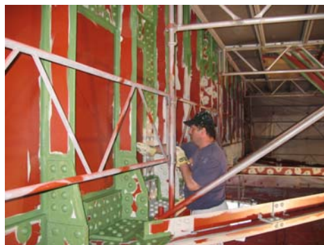
Storstrømsbroen - udstikning af tværdrager
